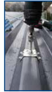
ETASOL Schraube in die Unterkonstruk- tion schrauben
