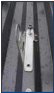
Schneestütze aufsetzen. Sicherheits- mutter etwas anziehen aber locker lassen
