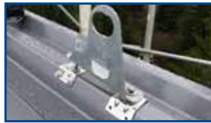
SK8/Sechskantschraube/Dichtscheibe mit Stütze zusammen montieren
