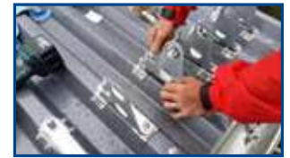
Sicherheitsmutter fest anziehen
