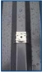
Kalotte auf Hochsicke setzen
