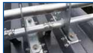
Schneestopper auf unterem Rohr befestigen
