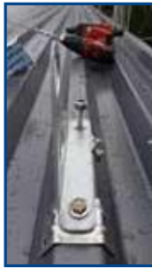
SK8/Sechskantschraube/Dichtscheibe mit Stütze zusammen montieren
