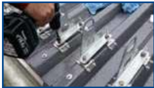
Sechskantschraube mit Dichtscheibe fest anziehen
