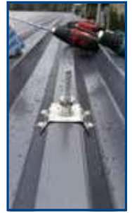
Sicherheitsmutter und Mutter entfernen
