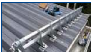
Obere und untere Alurohr- profile einschieben
